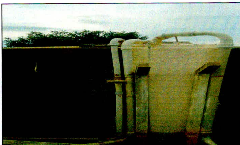
Figura 20- Reservatório em concreto armado
