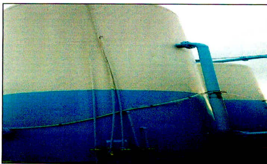
Figura 19- Sistema de filtragem da ETA
