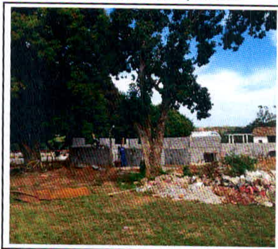
Figura 10 – Destinação de demolição e ferro
