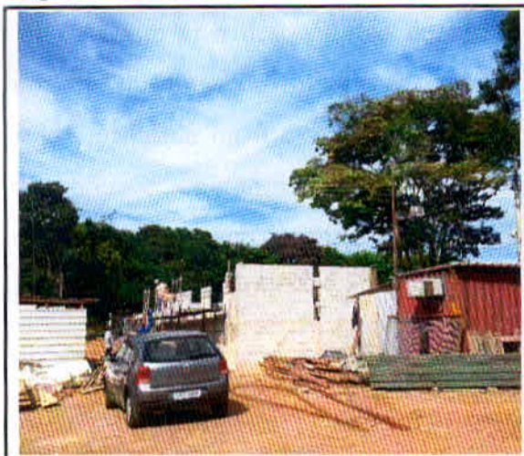
Figura 3 – Canteiro de obras
