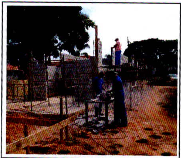
Figura 14 – Corte de bloco estrutural
