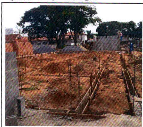
Figura 18 – Proteção das ferragens
