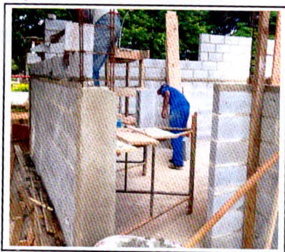
Figura 15 – Levantamento de bloco
