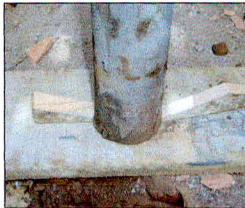
FIGURA 19: Cunhas para a realização da contra flecha (MATTOS,2009)
