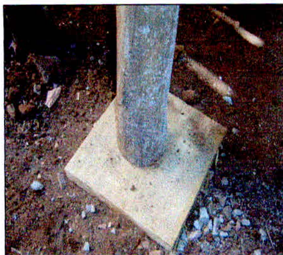
FIGURA 16: Base de distribuição do carregamento no solo (MATTOS,2009)
