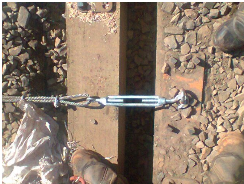
Figura 11: - Esticador para cabo de aço
