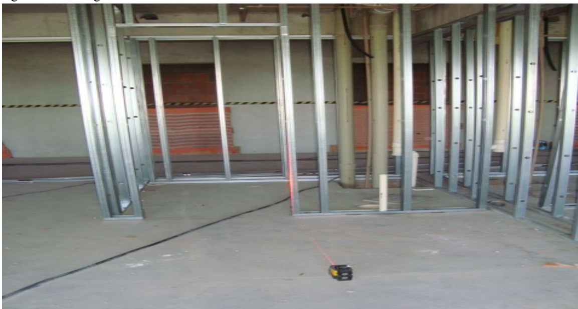
Figura 03: Montagem de montantes
