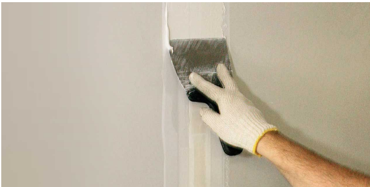
Figura 05: Aplicação de rejunte
