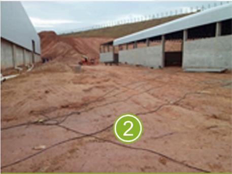
**FIAÇÃO PASSANDO PELO PISO SEM PROTEÇÃO**
