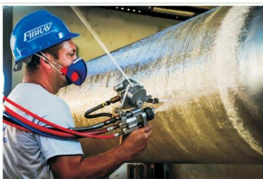
Figura 08 - Laminação com pistola sendo executada por laminador.
