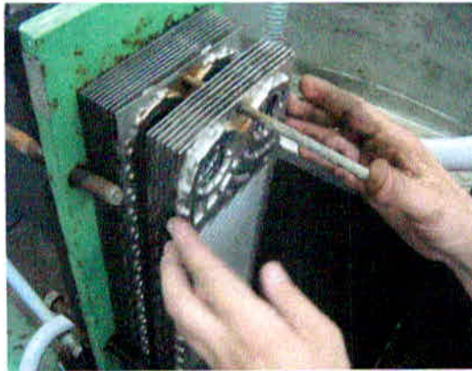
Foto 06: Colocação de oito placas para ampliação do trocador de calor. Fonte: O Autor.
