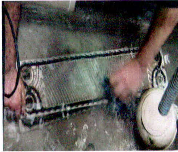
Foto 08: Limpeza das placas incrustadas. Fonte: O Autor.
