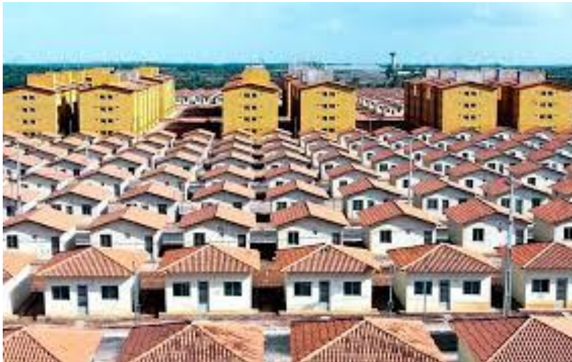
Figura 6 – Conjunto habitacional MCMV
