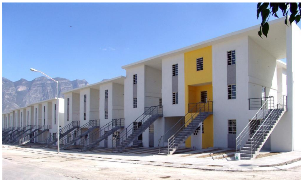
Figura 26 – Ampliação pelo proprietário
