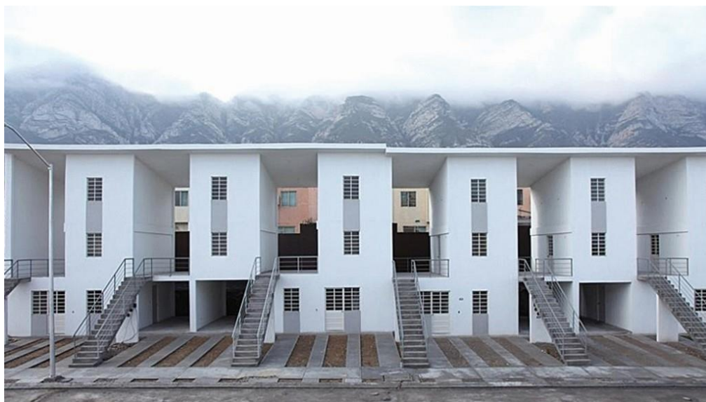
Figura 23 – Fachada do conjunto de 70 moradias populares
