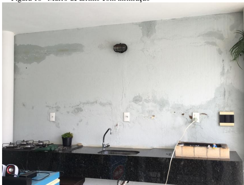
Figura 18– Murro de arrimo com infiltração
