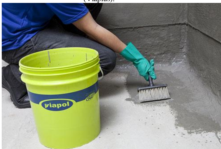
Figura 6 – aplicação de membrana com polímero modificado com cimento (Viapol).
