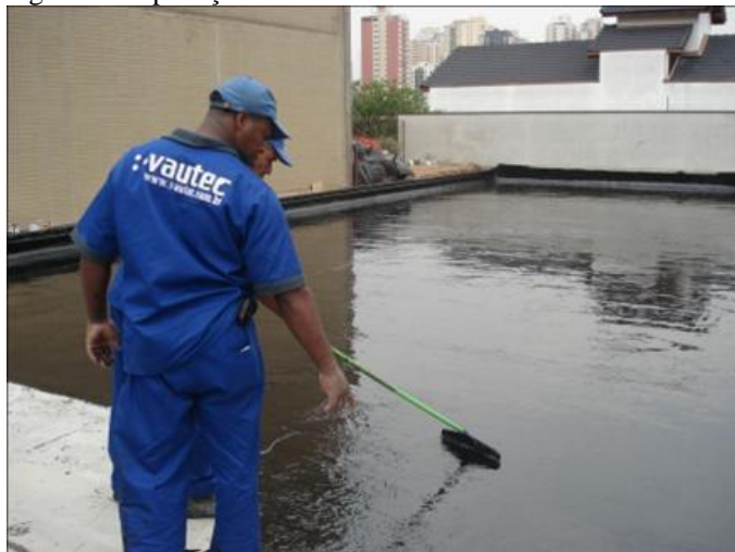
Figura 7 – Aplicação de membrana asfáltica - VEDAPREN
