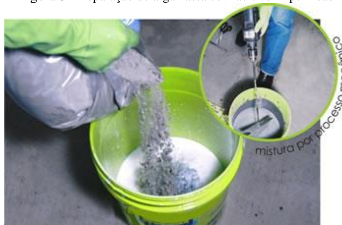
Figura 3- Preparação de argamassa com aditivo impermeabilizante
