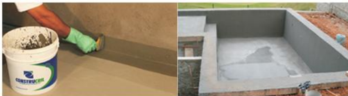
Figura 8– Aplicação de membrana acrílica
