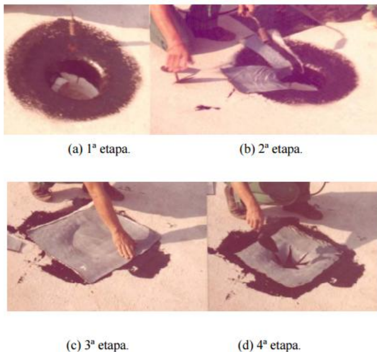
Figura 13– Execução de arremate de impermeabilização junto ao ralo.
