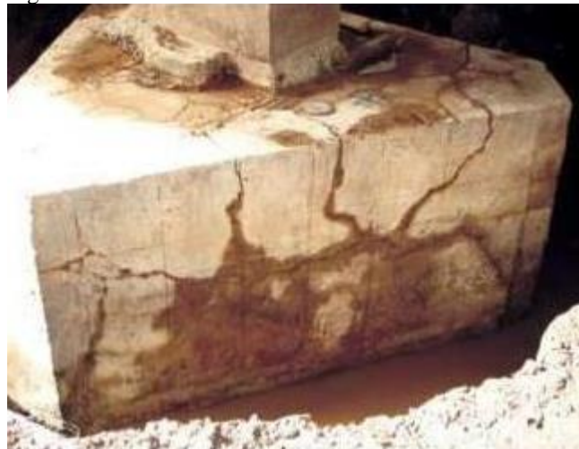
Figura 2 - Estrutura com RAA
