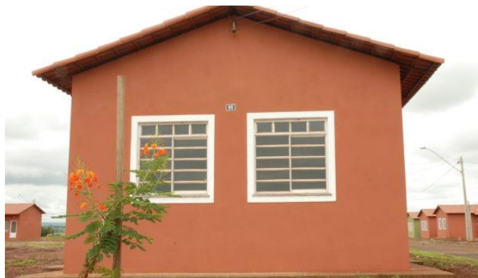
Figura 5 - Vista frontal da casa padrão Cohab
