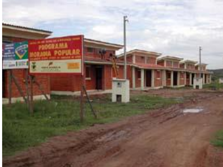
Figura 2 - Estágio final de conclusão do projeto CETHS
