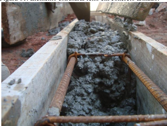
Figura 01: Elemento estrutural feito em concreto armado.
