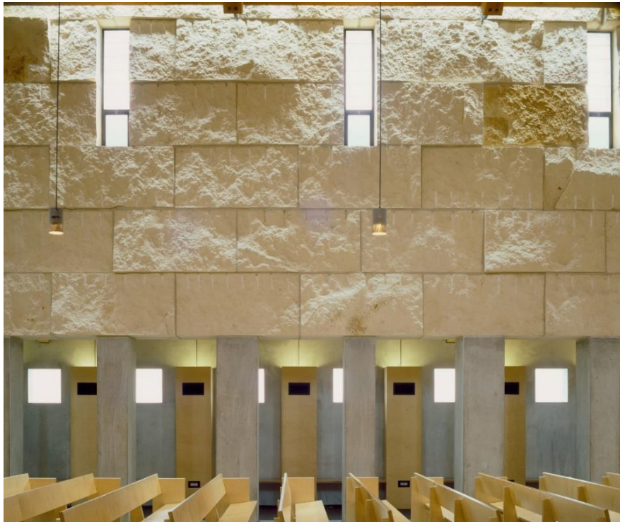
Figura 15: Detalhe interno: assentamento dos blocos - Igreja da Abadia Fonte: Arch Daily
