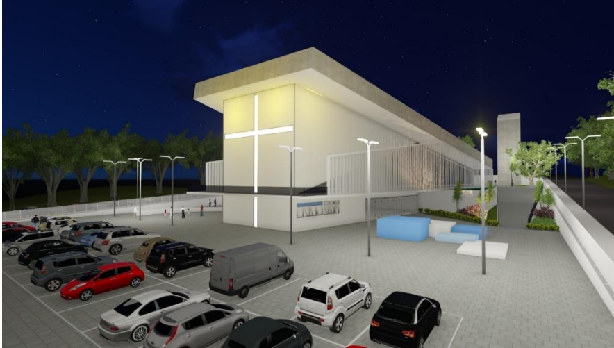
Figura 64: Fachada lateral esquerda
