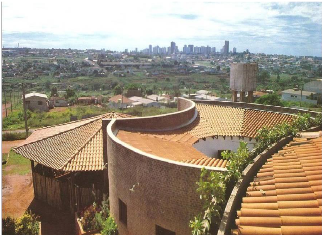
Figura 12: Detalhe da cobertura – Espírito Santo do Cerrado Fonte: Skyscrapercity
