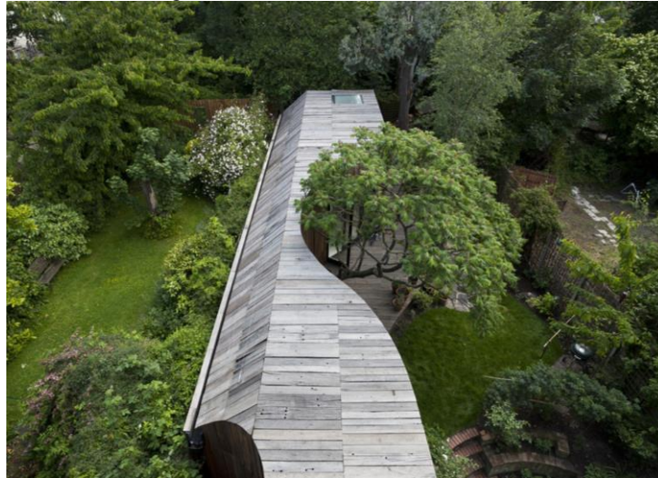
Figura 15 – Cobertura da Casa Árvore
