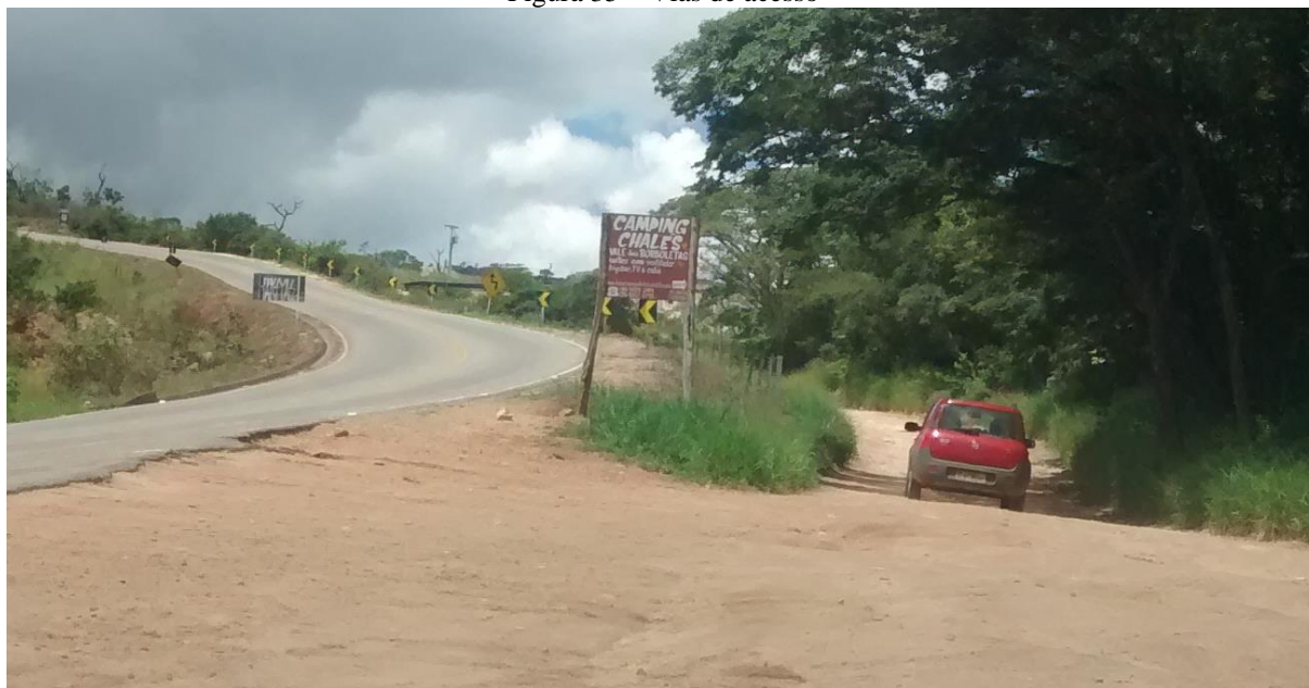
Figura 35 – Vias de acesso
