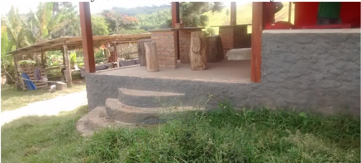
Figura 37 – Escada de acesso ao bar do sr. José F. Alvarenga
