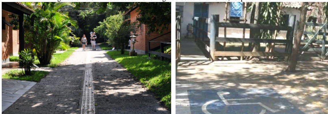
Figuras 01 e 02 – Rota acessível e vaga de estacionamento, respectivamente
