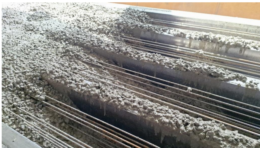
Figura 3 - Concreto espalhado nas formas.
