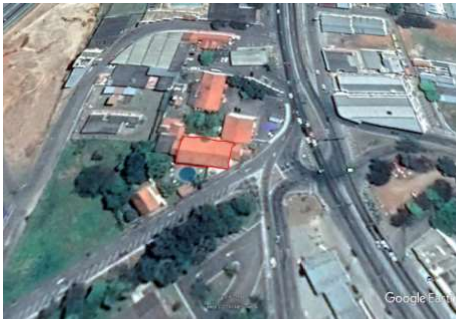
Figura 3: Telhado do hotel.
