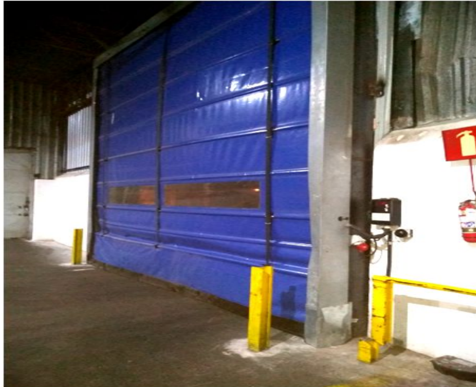
Figura 6 - Porta instalada fechando a frente da fábrica.
