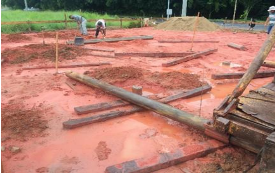
Figura 05 - Chuvas prolongadas inundam algumas estacas
