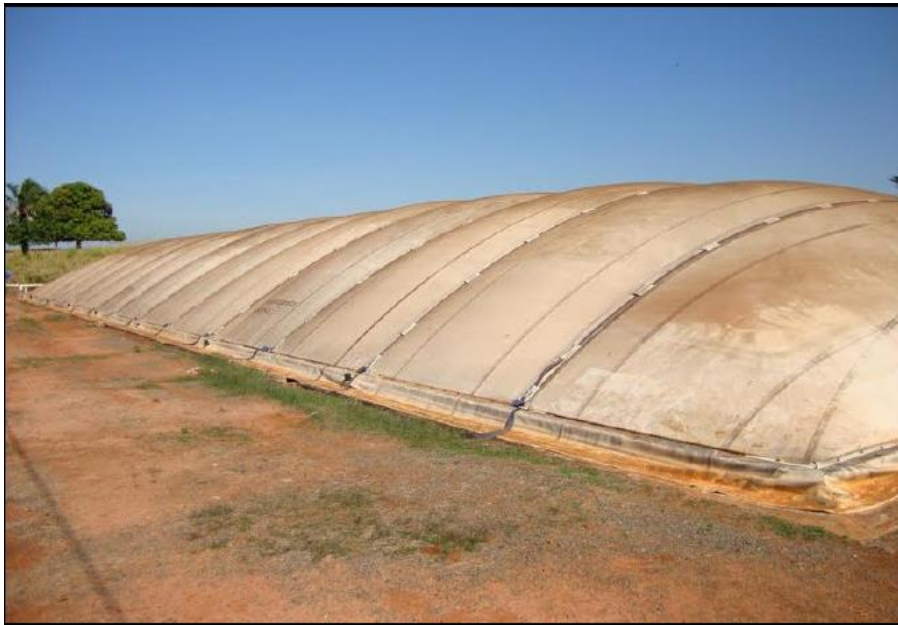
Figura 06 – Representação do biodigestor modelo Canadense.
