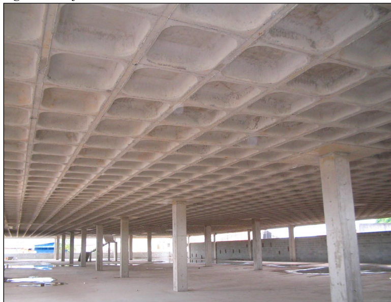
Figura 2: Laje nervurada concretada.
