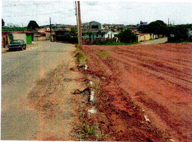
Figura 31-Ausência de vegetação no sistema viário
