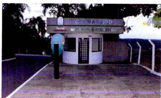
Fig. 37 - Portaria de acesso. Fonte: o autor, 2017.
