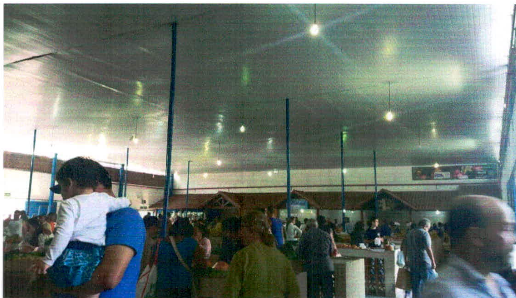
Figura 5-Pilares metálicos que sustentam a cobertura e forro de PVC no bloco principal do mercado.
