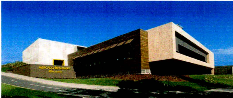
Figura 35- Vista das fachadas frontal e lateral esquerda da edificação.
