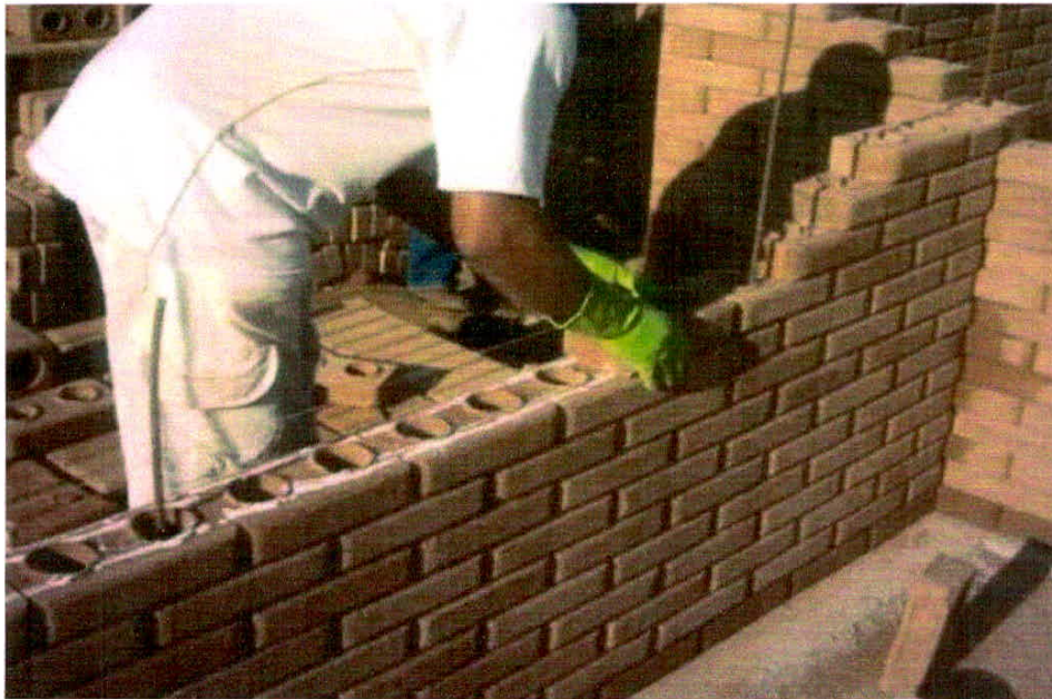
Execução de parede em Bloco de Terra Compactada.
