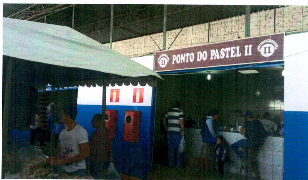
Figura 6-Lanchonetes de um dos blocos construídos com sistema lage-viga-pilar e cobertura metálica.
