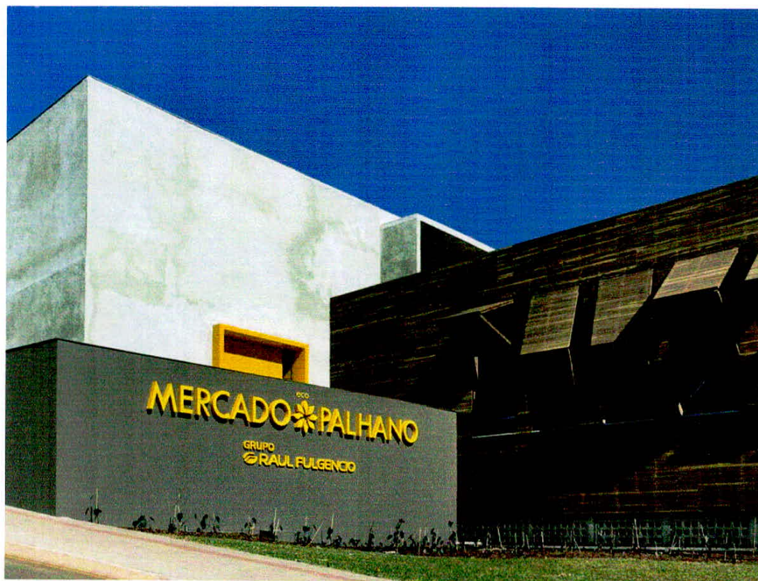
Figura 32- Fachada principal da edificação.
