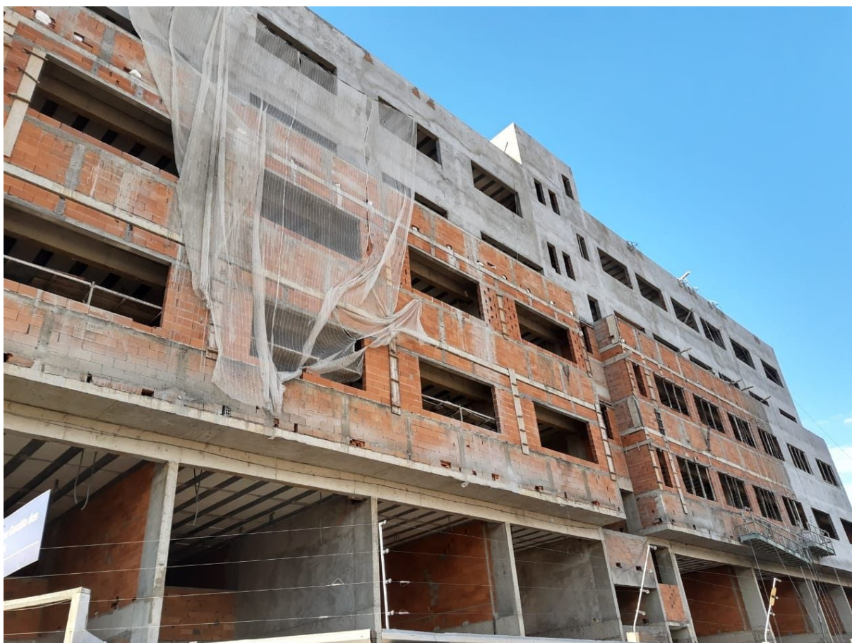
Figura 1: Fachada da obra
