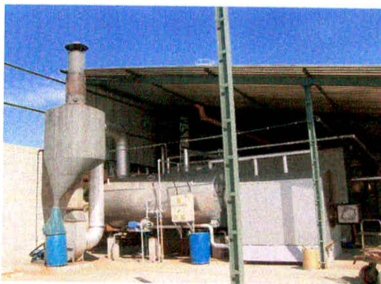
Figura 07 – Caldeira flamotubular com ciclone instalado. Fonte: Lynhanil (2010).
