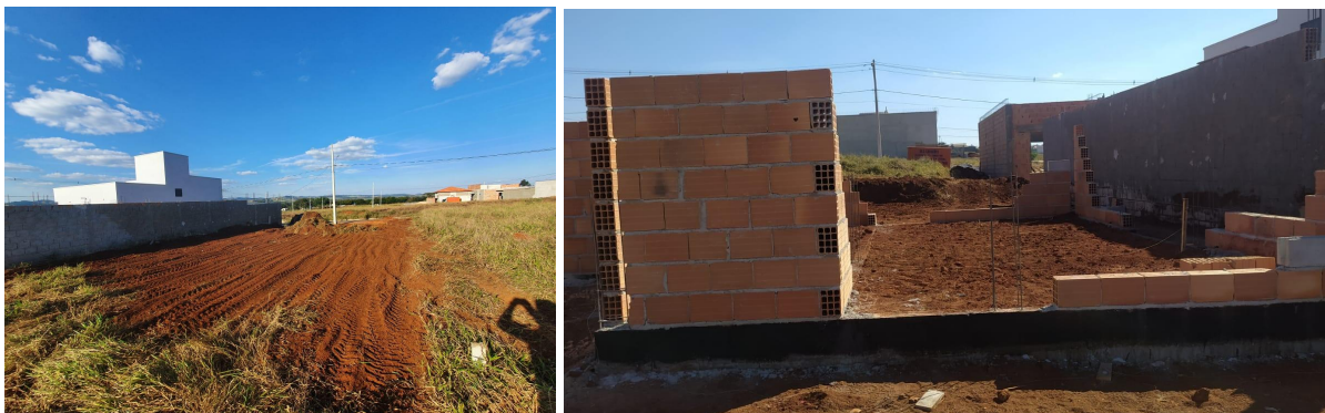
Figura 4 – Local da obra
