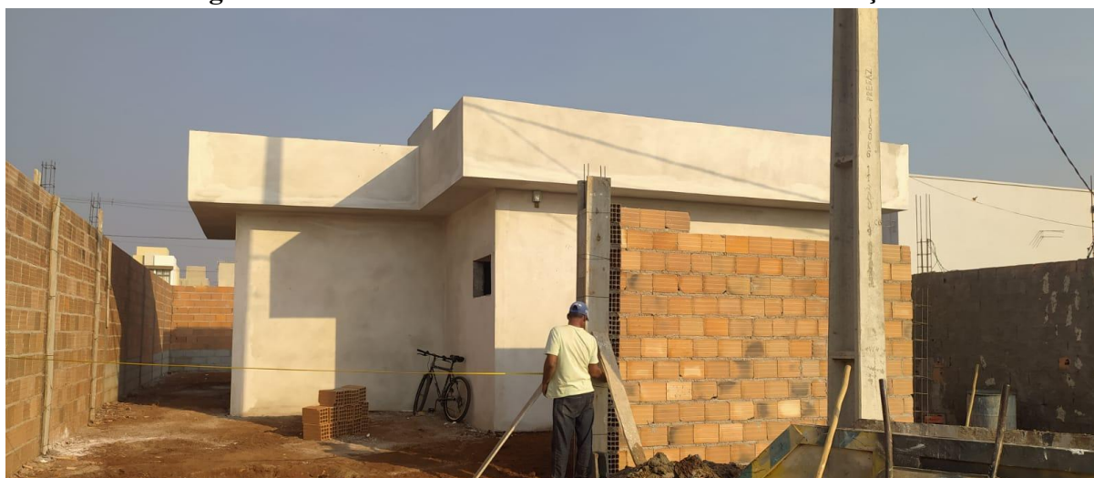
Figura 5 – Andamento da obra com um mês de construção.
