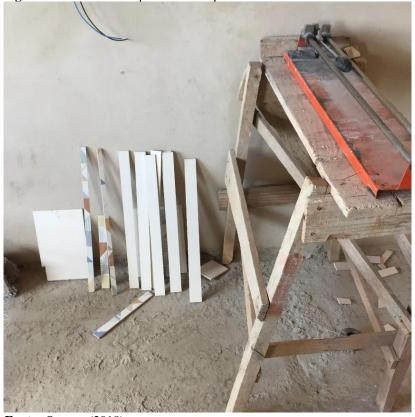
Figura 08: Cortadora de piso utilizada para corte dos revestimentos cerâmicos.
