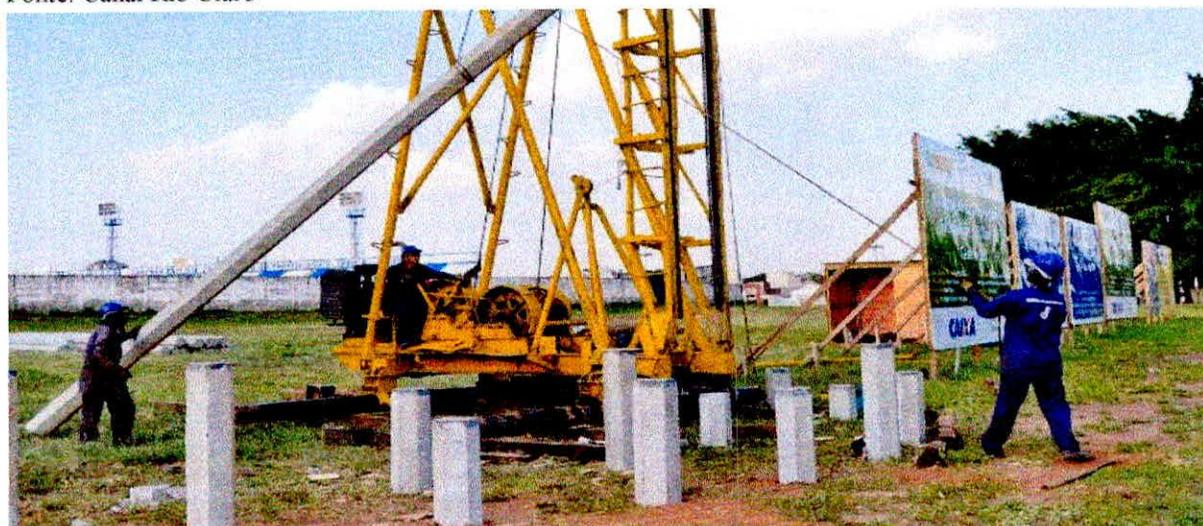
Figura 1: Estacas de concreto pré-fabricado
