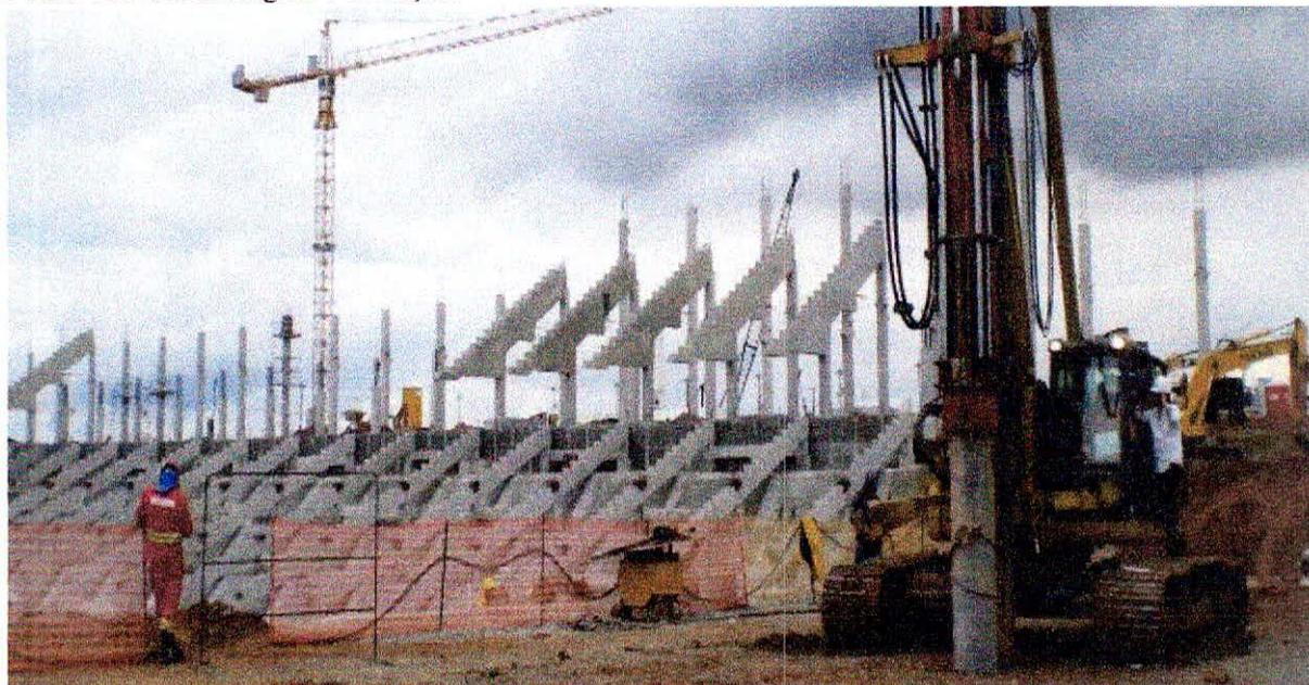
Figura 2: Estaca de concreto pré-fabricado, cravação a percussão
