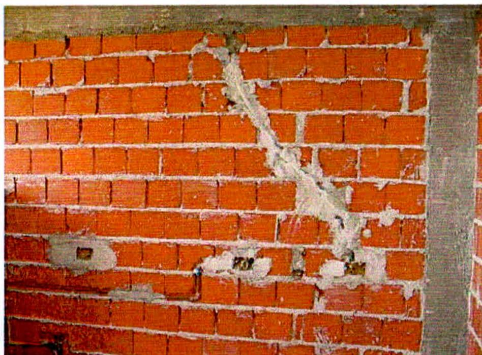
Figura 19: instalações embutida na parede
