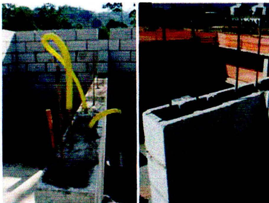
Figuras 24 e 25: Graute e ferragem na alvenaria estrutural.
