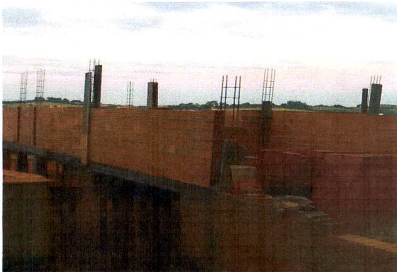
Figura 17: Estrutura de concreto armado , necessidade de formas ;
