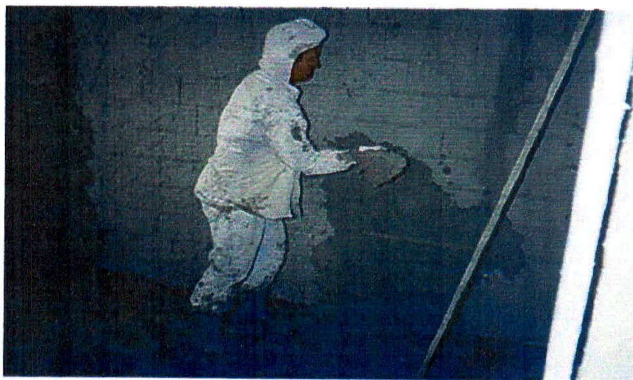
Figura 18: Parede chapiscada e rebocada;
