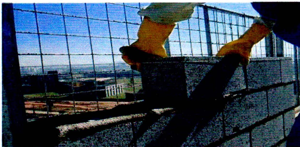
Figura 23: Assentamento de blocos de concreto: juntas devem possuir aproximadamente 1 cm.
